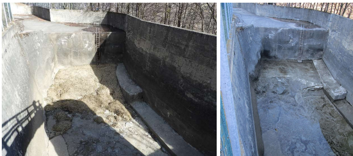
Figura 4: Depositi di materiale e placche di calcestruzzo distaccate sul fondo della vasca. Sinistra: prima della pulizia, destra: a seguito della pulizia svolta nell'inverno 2021
