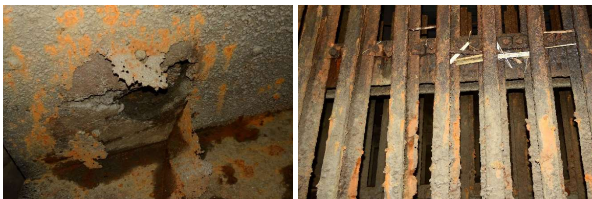
Figura 22: Danni alla blindatura della camera di dissipazione e ai dissipatori di energia.
