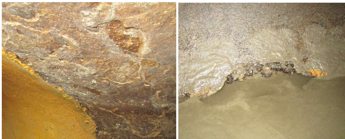
Figura 21: Danni limitati all'intonaco e distacchi nel condotto di aspirazione della turbina 1.
