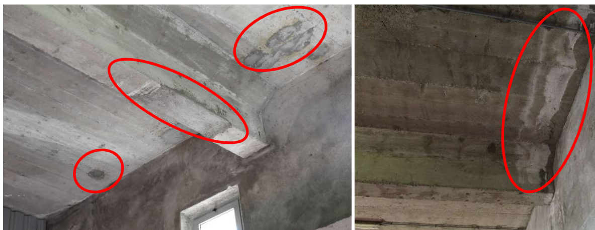
Figura 10: Interventi di riparazione del copriferro degli architravi della soletta
