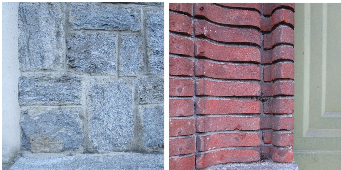
Figura 18: Dettaglio muratura in pietra (sinistra) e in cotto (destra)
