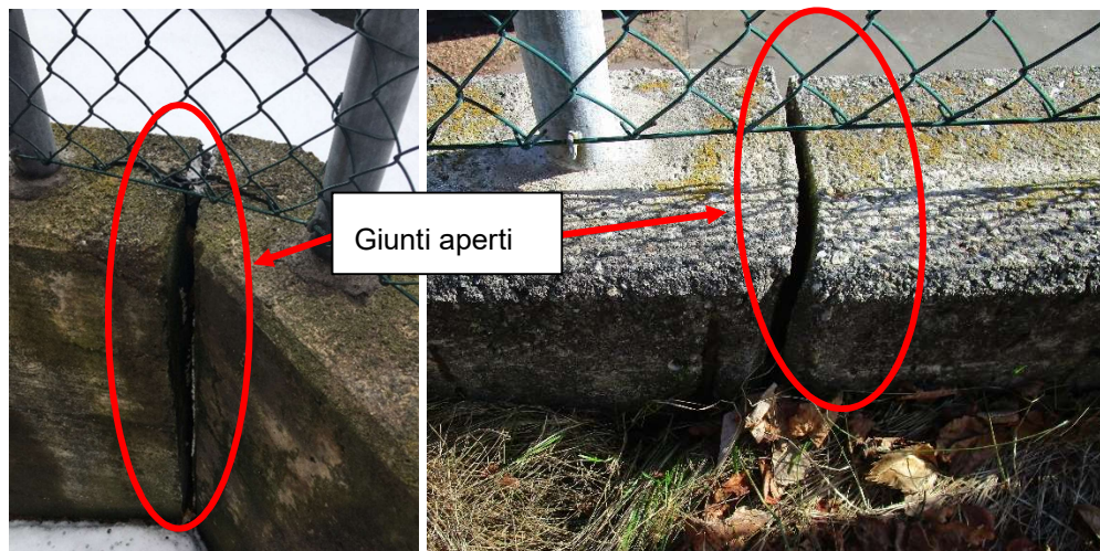
Figura 3: Giunti di dilatazione aperti.
