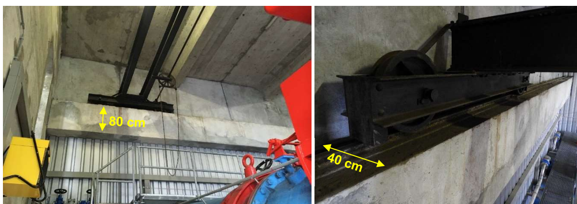
Figura 7: Dettaglio del carroponete. Sinistra: vista lato a monte della camera valvole, destra: dettaglio del binario di scorrimento, lato monte
