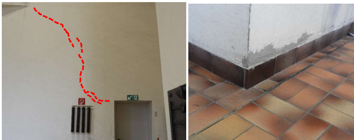
Figura 17: Fessura obliqua nel muro frontale nord-ovest e cedimento differenziale nel pavimento
