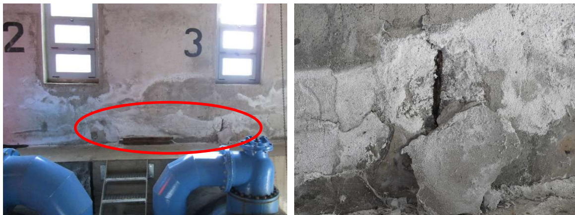
Figura 9: Zona della parete sud-est in cui si sta staccando il copriferro.
