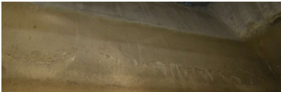
Figura 23: Fessura orizzontale sul lato nord della camera di espansione.
