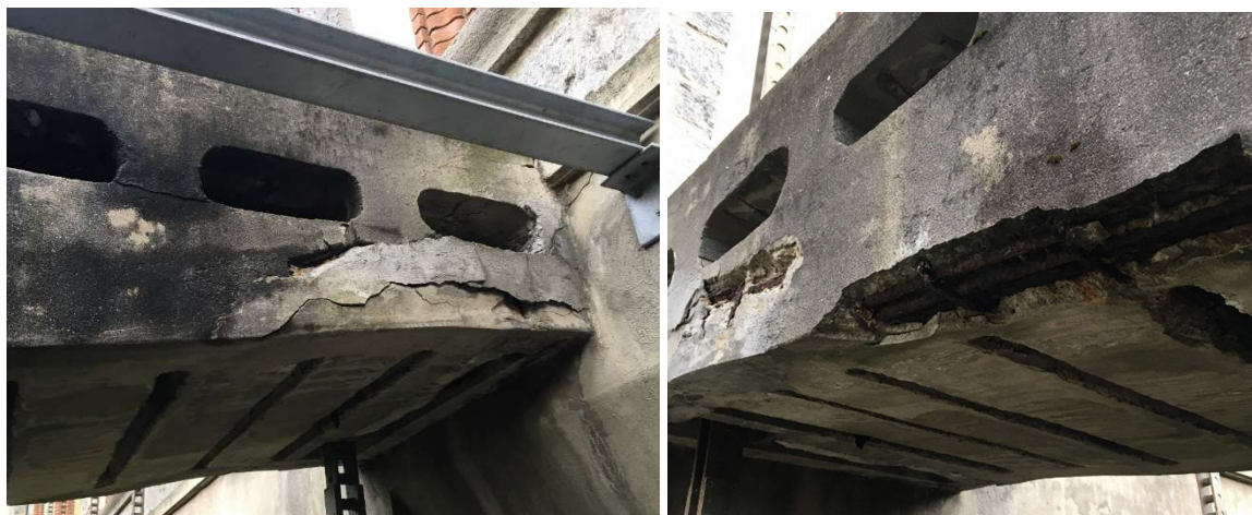
Figura 20: Stato di conservazione canale cavi generatore-trafo
